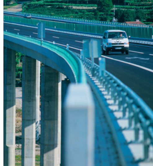
Nouvelle autoroute reliant Porto à Valença do Minho (à la frontière de la Galice), Portugal
