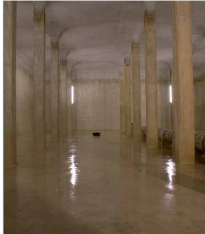
Réservoir souterrain d'eau potable
