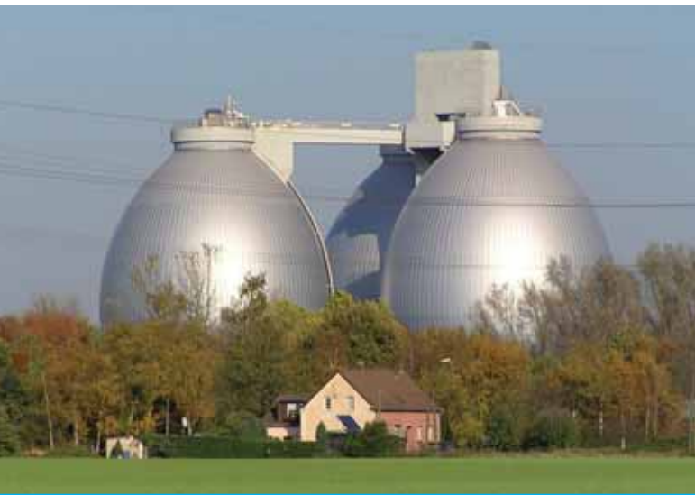
Digesteurs anaérobies, station d'épuration des eaux usées «Emschermündung» (Allemagne)
