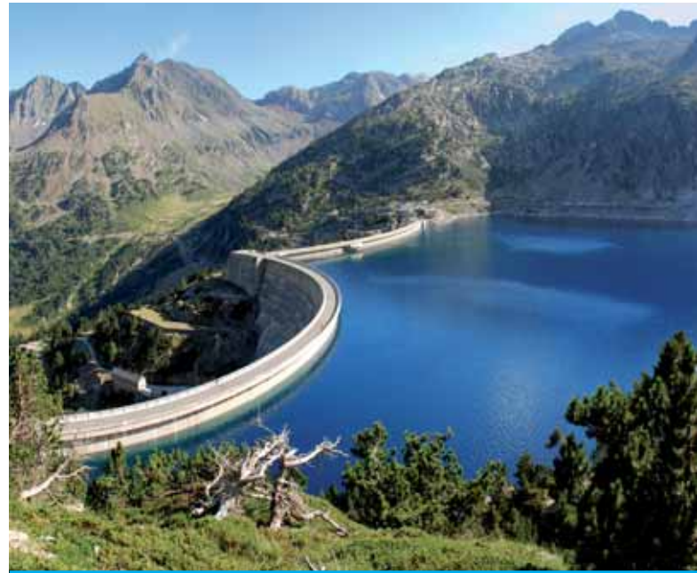
Barrage Lac de Cap-de-Long (France)
