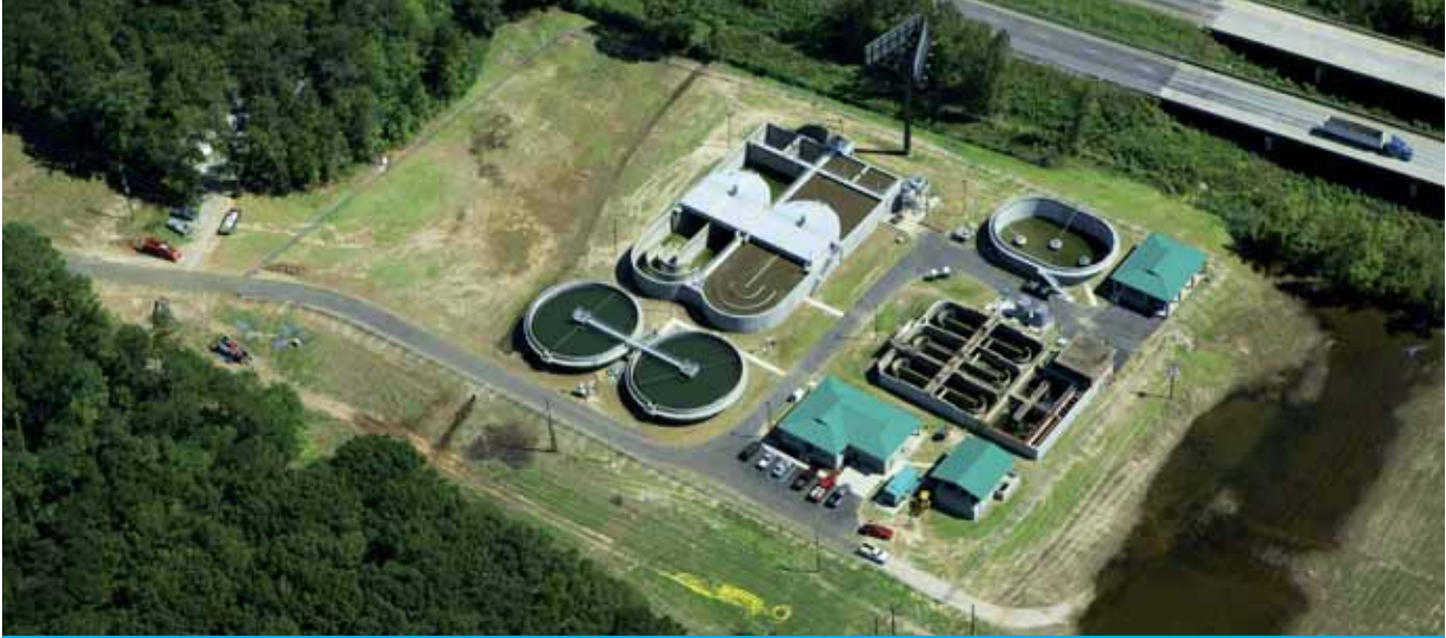
Station d'épuration des eaux usées
