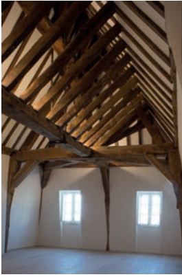
Charpentes du 3 e étage
