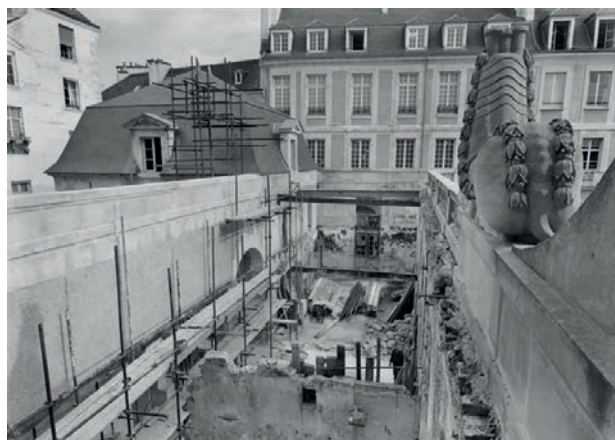
Vue extérieure du chantier, 1981
